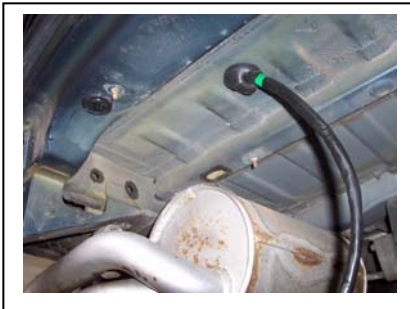
Kabeldurchführung, Bohrung vorhanden
